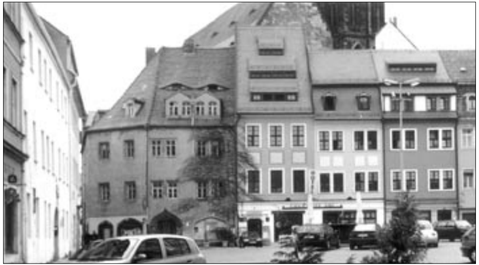
Häuser am Untermarkt, links vom Pirnaischen Hof das Peter-Ulrich-Haus (Markt 3), benannt nach dem Baumeister der Pirnaer Marienkirche, der sich hier seinen Wohnsitz errichtete. Foto: J. Klvetasch.
