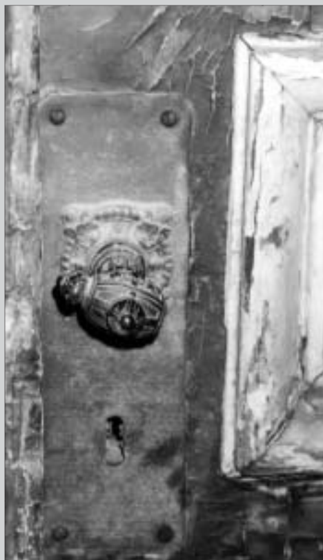
Auf der Gartenstraße kann man eine Vielzahl einander ähnlicher Türen und Klinken finden. Die Klinkenrosette stammt etwa von 1880. Leider kam das alte Schlüsselloch im Laufe der Zeit abhanden und wurde im 20. Jahrhundert notdürftig durch ein Langschild ersetzt.
