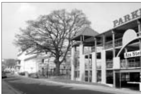
Anstelle von kleinen Gärten steht nun das hochwassergefährdete Parkhaus.
