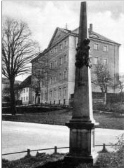
1905 stand die Postmeilensäule nach mehrfachem Umsetzen vor dem Tischerstift. Jetzt befindet sie sich auf der Grohmannstrasse. Im Hintergrund das ehemalige Landhaus von Dr. Tischer, das mehrfach umgebaut wurde. Bild: „Pirna - Bilder der Vergangenheit“
