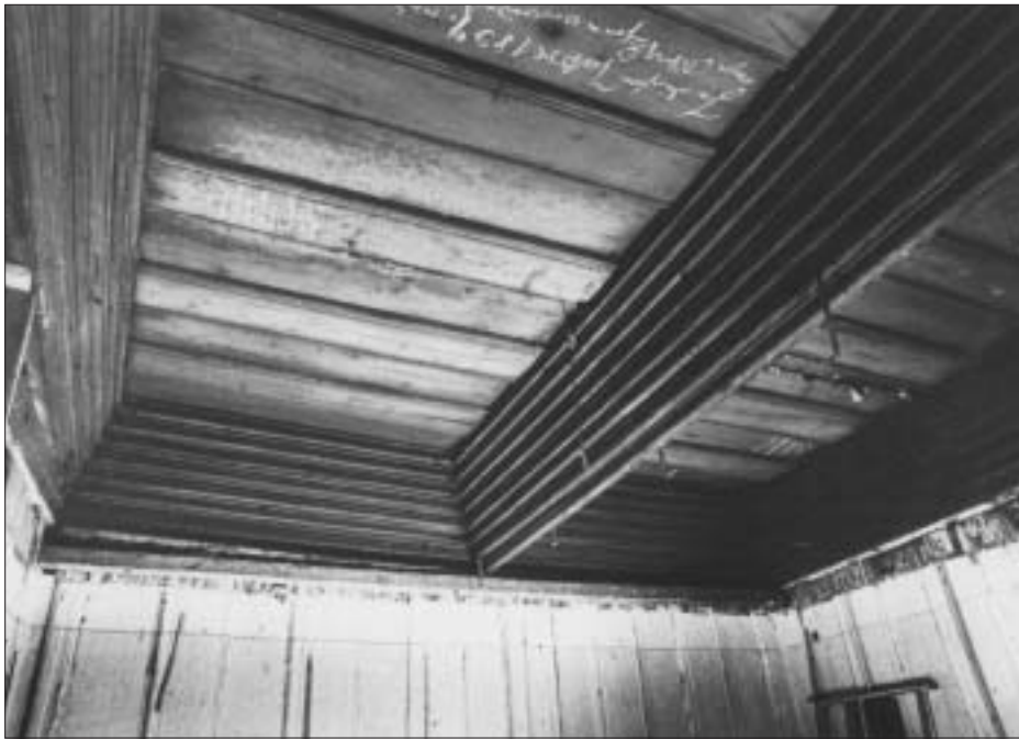
Die Gotische Decke der Bohlenstube im Tetzehaus. Die Balken sind aus mehreren Stämmen zusammengesetzt, die Profilierung verleiht dem Raum eine schnörkellose Eleganz. Foto: Johann Klvetasch, 1993
